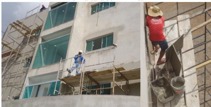
Figura 2. Obra com andaimes sem tela de proteção, guarda corpo e funcionários realizando trabalho em altura sem EPI's.
