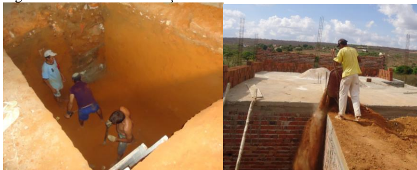
Figura 3. Obras sem sinalizações de aberturas e funcionários sem EPI's.
